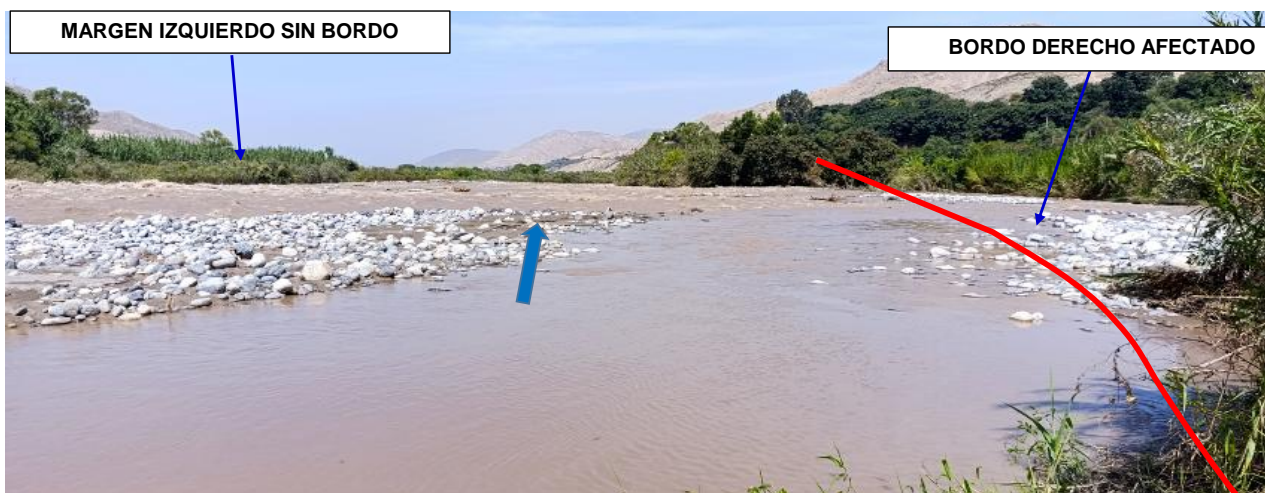
FIGURA N°02: RÍO CHANCAY-HUARAL, SECTOR QUIPULLIN Y LUMBRA SIN BORDO EN LA MARGEN IZQUIERDA Y DERECHA RESPECTIVAMENTE, PONIEDO EN RIESGO LAS ÁREAS DE CULTIVO EN AMBOS LADOS DEL RÍO.
